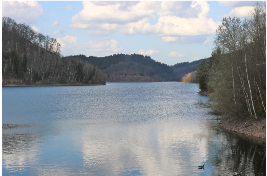
Talsperre Nonnweiler – Blick vom Staudamm nach Nordosten
