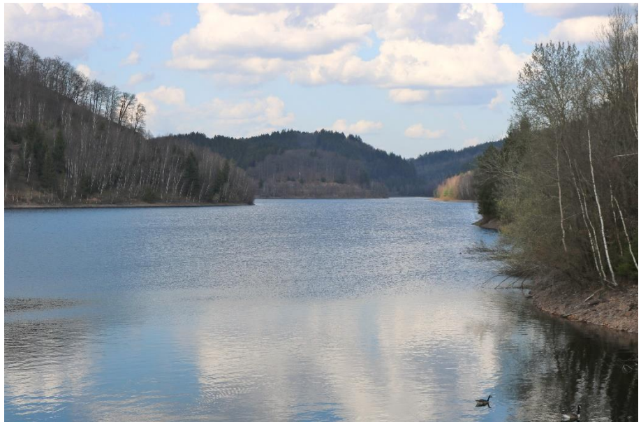
Talsperre Nonnweiler – Blick vom Staudamm nach Nordosten
